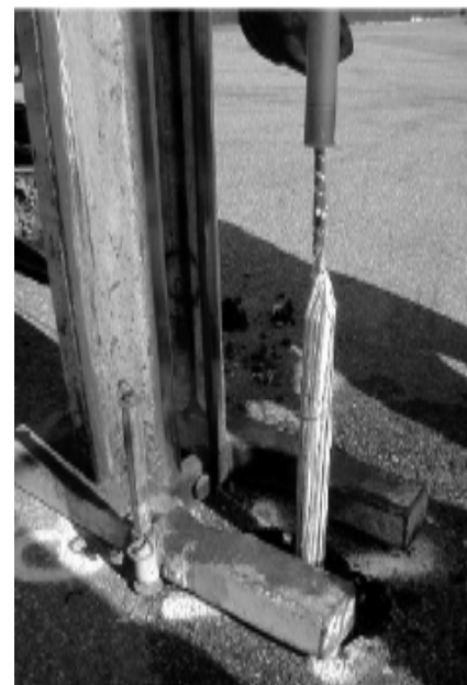
Figur 4. Sidste rør trukket op og membranen fuldt ekspanderet med vand.
